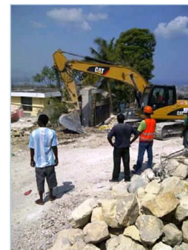
Démolition de maison
