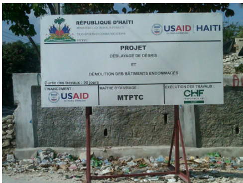
Placard sur le site du projet Ce projet est exécuté en collaboration avec le MTPTC.
