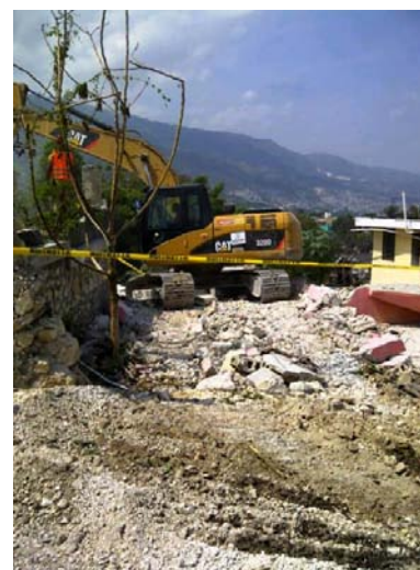
Démolition d'une maison « rouge »
